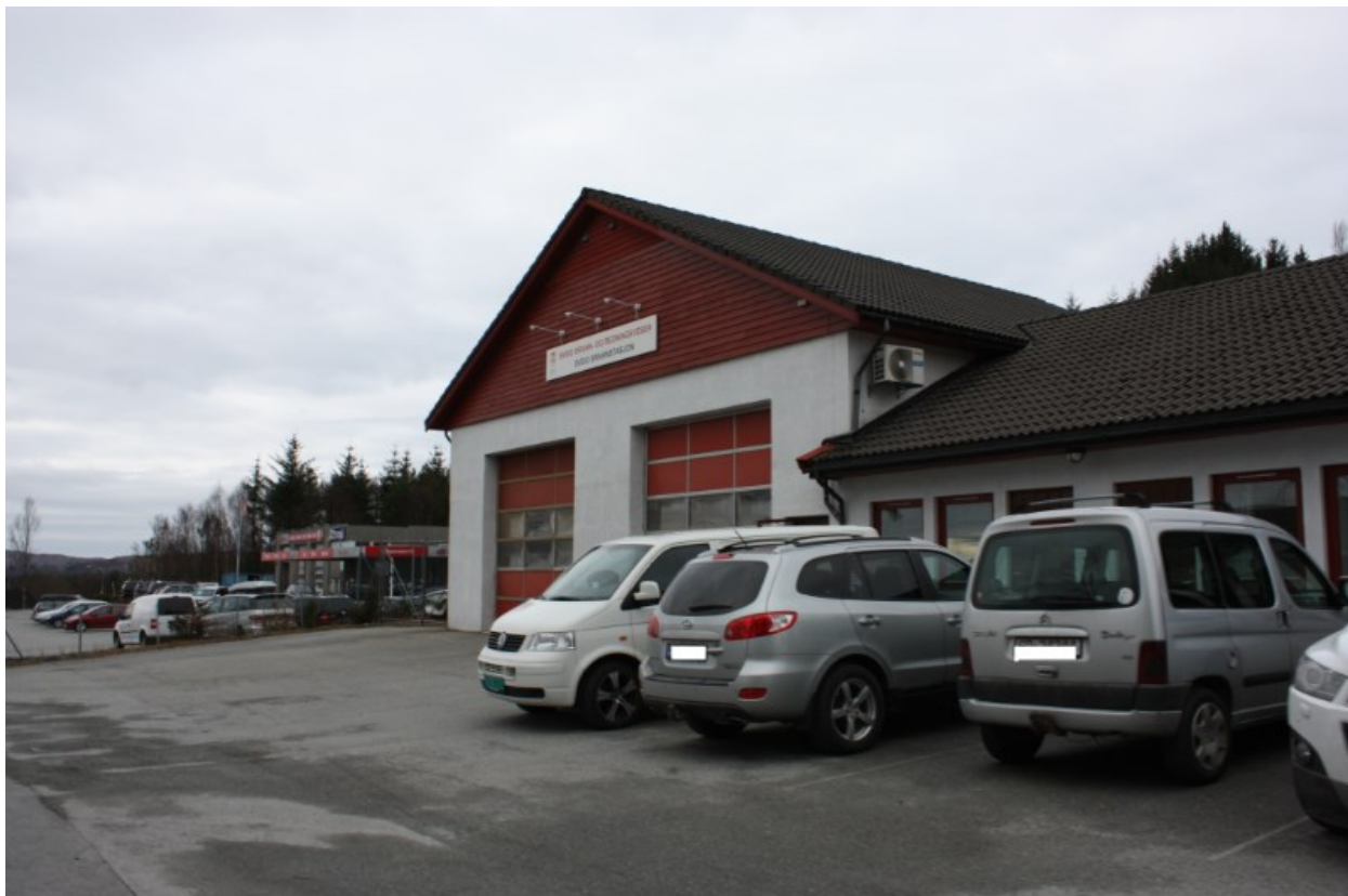
Eksisterande brannstasjon langs Leitevegen.
