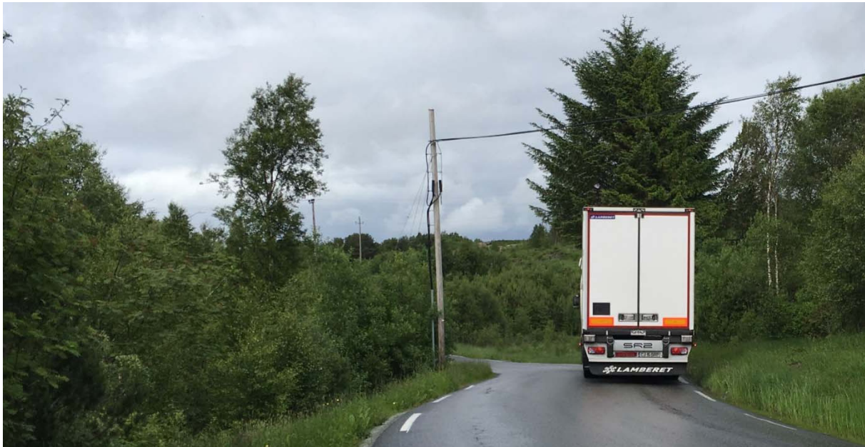
Figur 35 Dagens fylkesveg er smal og har vanskelege siktforhold.
