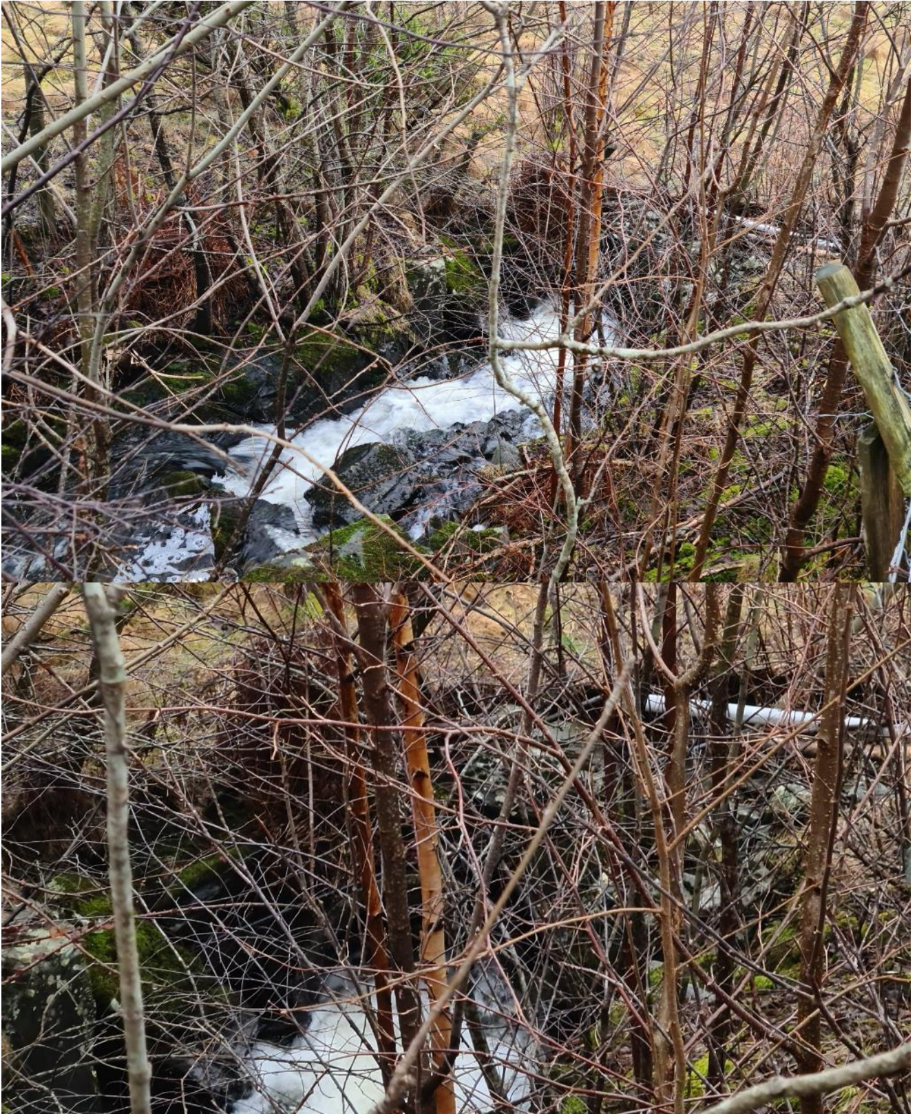
Figur 18 Bilder ved B10 som syner inntak. Litt mykje trer i vegen, men her kan ein sjå at det har runne over til høgre for røret. Fyllingsgrad ca 50%.
