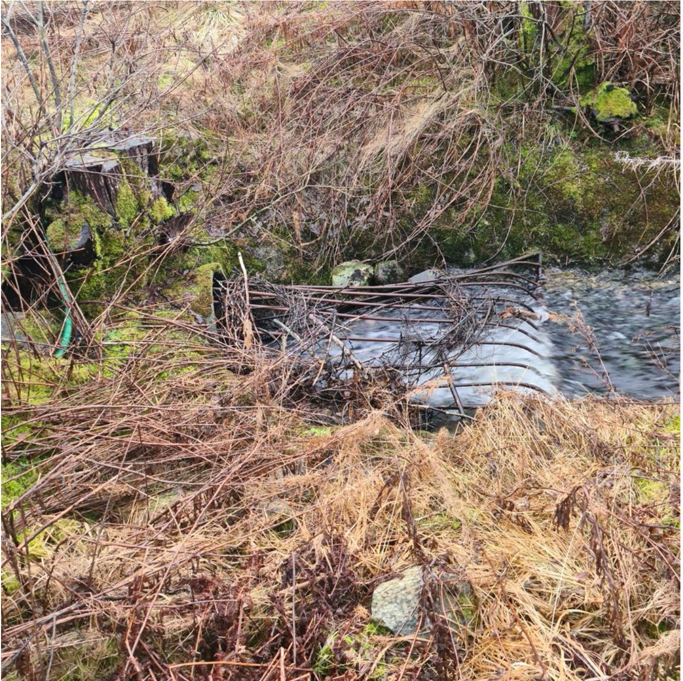
Figur 14 Bekkeinntak ved B7 som også kommunen reinskar. Kan sjå at vatnet har gått høgt her då det ser ut som det ligg rusk i nivå med topp rør.
