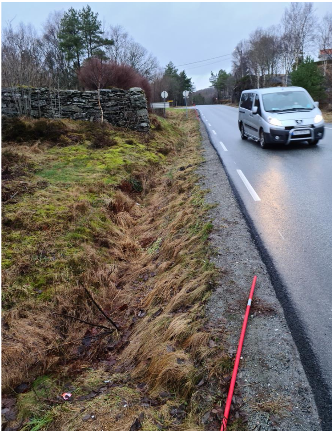
Figur 23 Vegggrøft langs Tjernagelvegen sett opp mot Paddevegen.
