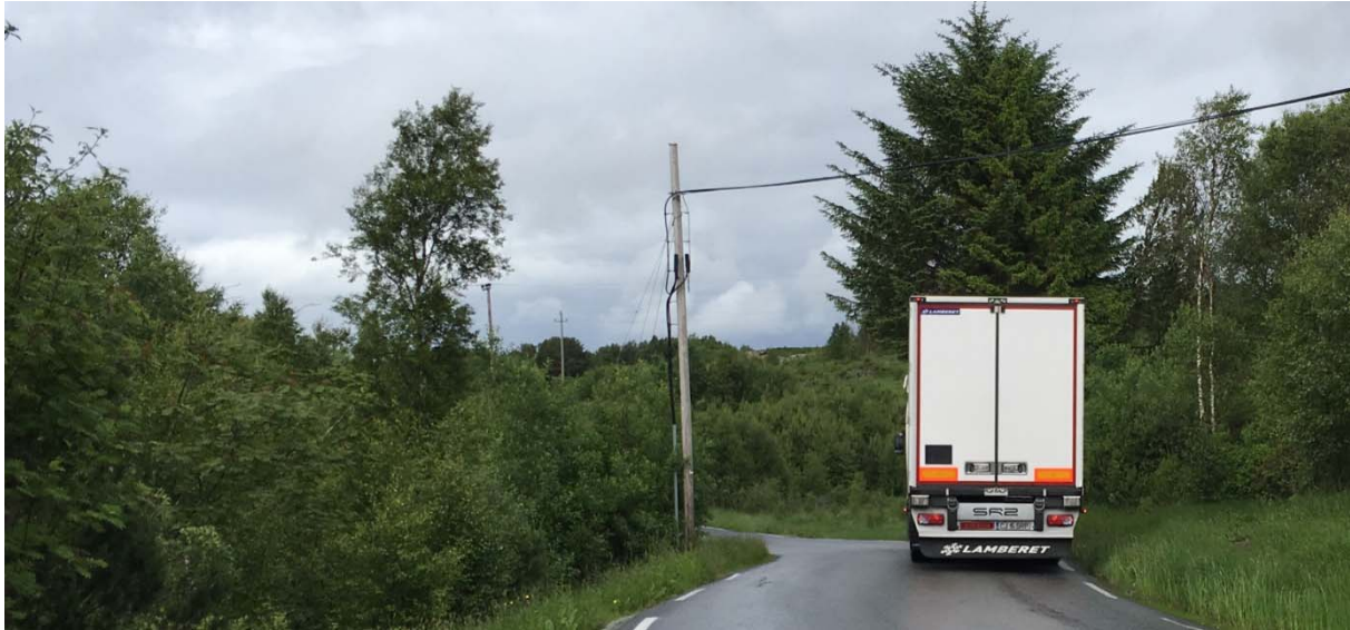
Figur 8 Dagens fylkesveg er smal og har vanskelege siktforhold.
