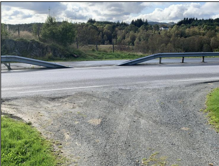
Figur 25 Opning i rekkverket for tilgang til gang- og sykkelveg
